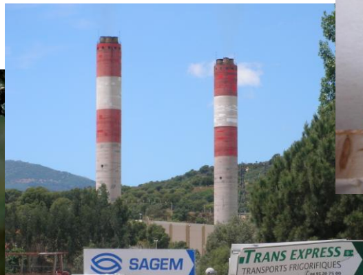
Centrale thermique du Vaggio
